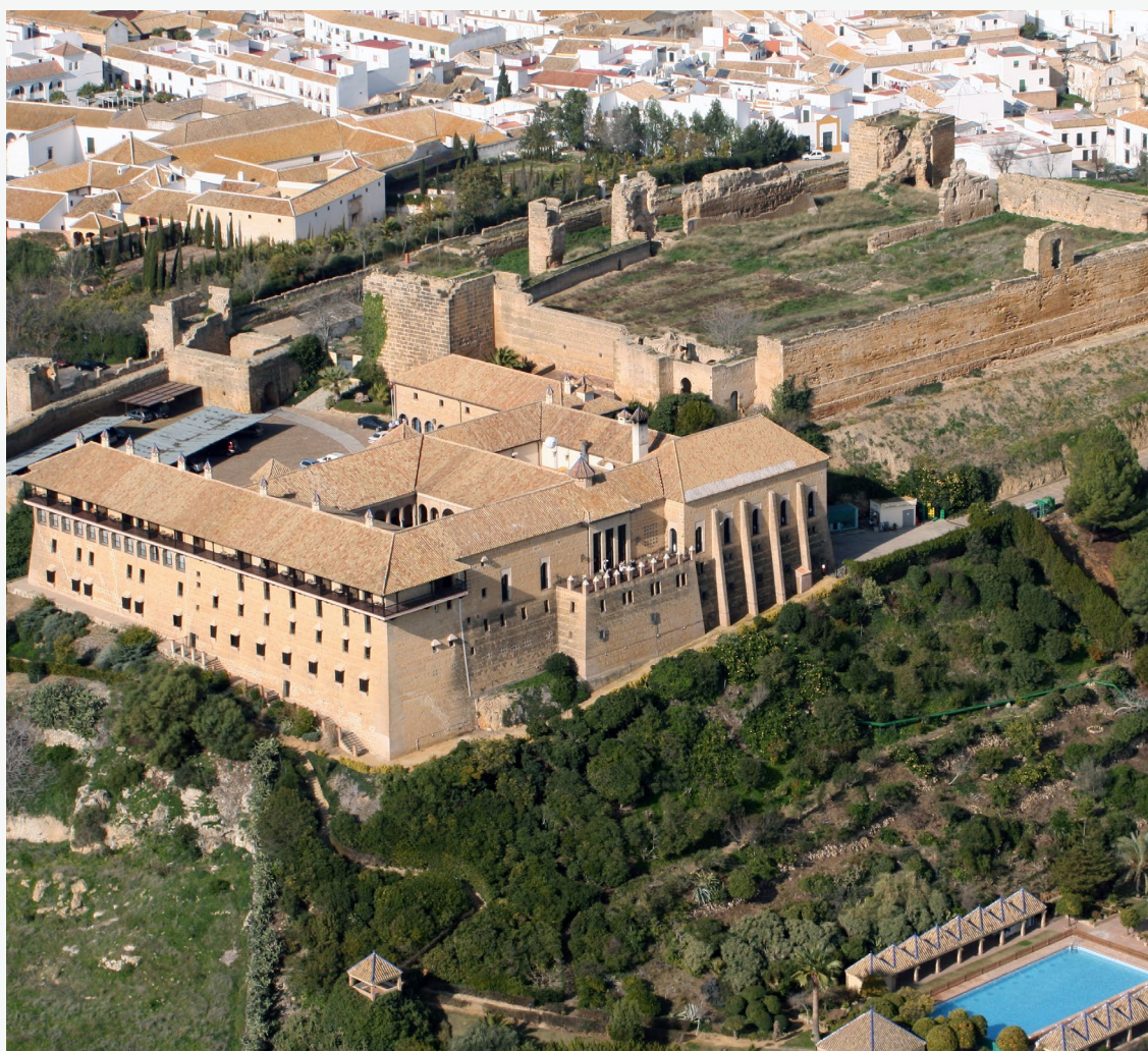
▲ PARADOR DE CARMONA SEVILLA
